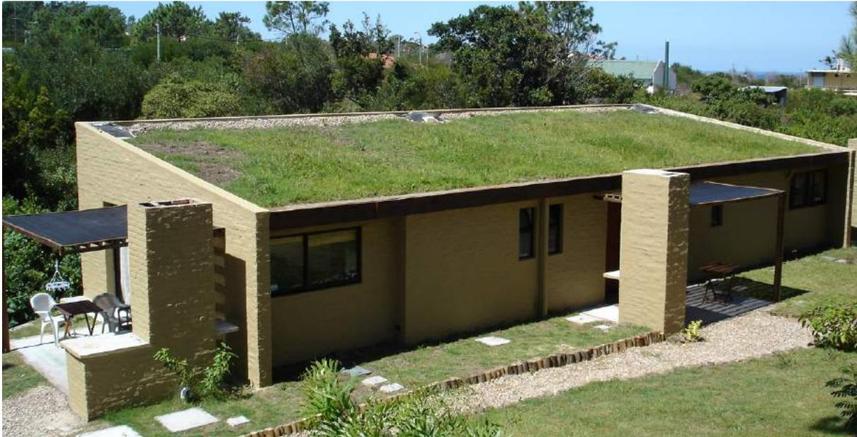
Una vez que el techo verde se instala correctamente, sus necesidades de mantenimiento suelen ser mínimos. Sin embargo, de los dos tipos básicos de sistemas de techos verdes, extensivo e intensivo, este último debido a su gran peso y plantaciones más intensas, tiende a tener mayores necesidades de mantenimiento sobre todo en la capa de las plantas y la capa de drenaje.
