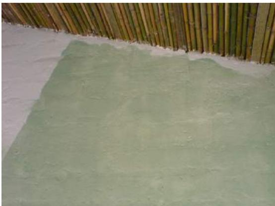
Las paredes de ADB-Concreto se pintan con una base de sellador de concreto transparente, sobre él se puede aplicar pintura de agua, estuco y pinturas naturales como el coralon o aquellas elaboradas artesanalmente con pigmentos de tierra.
